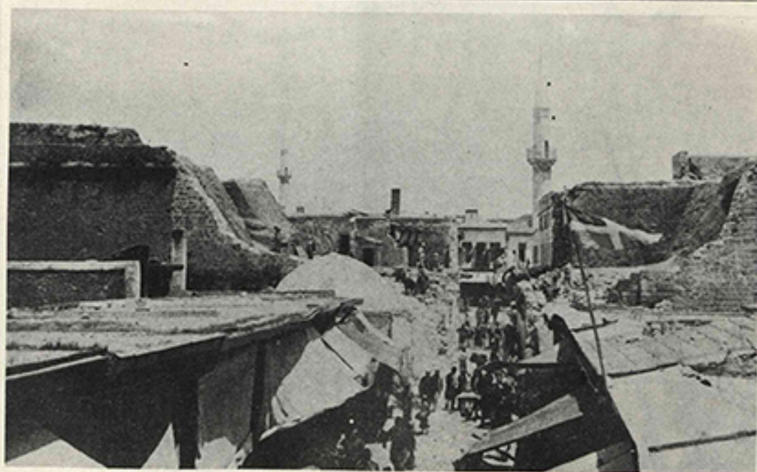
Η Porta Retimiotta (Καλέ - Καπίο) στην οδό Μουσούρων μετά την κατεδάφισή της στις αρχές του αιώνα.
