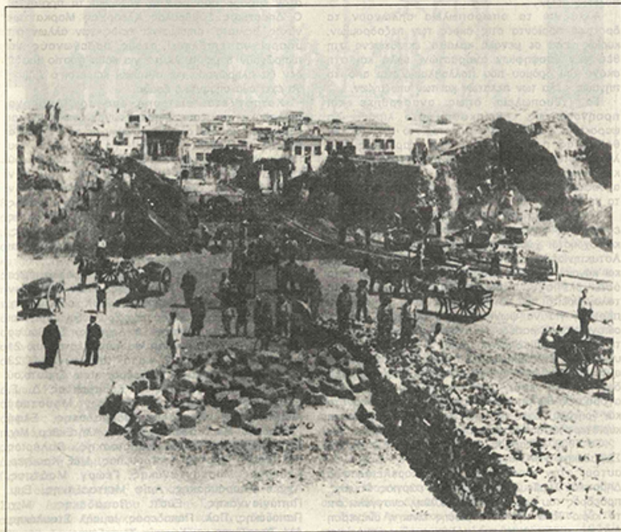
Εργα θεμελίωσης της Αγοράς.
