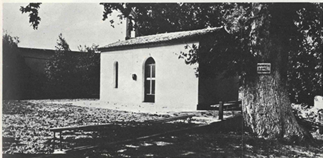
Ἀρμένιοι Ἀποκορώνου (ἀρ.: 15): Ἡ θέση τῆς Βασιλικῆς μετά τίς «ἀνακαινιστικές» ἐργασίες.
